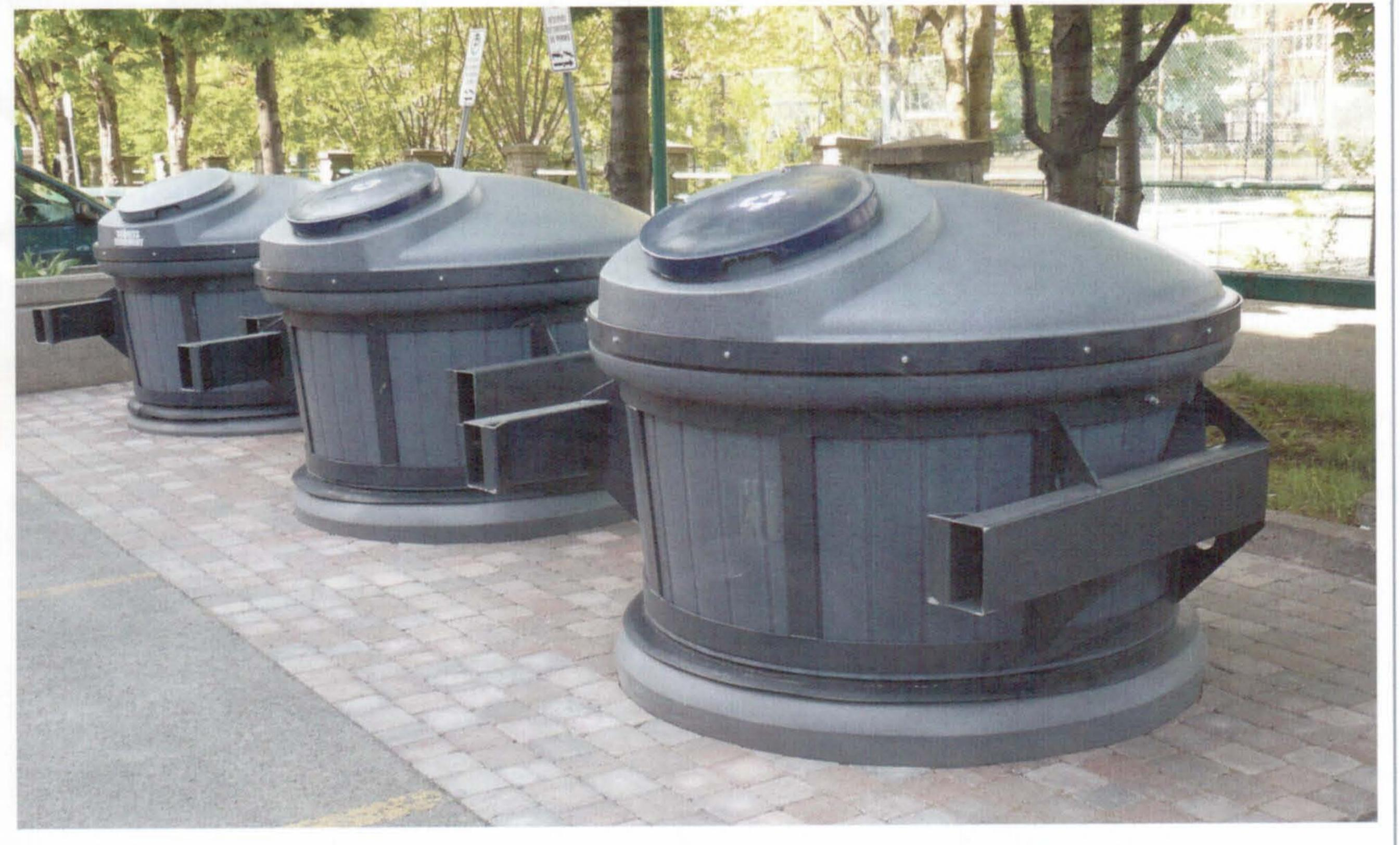
Les bacs semienfouis ont une capacité de 5 000 litres chacun, soit l'équivalent de 14 bacs roulants traditionnels d'une capacité de 360 litres. L'enfouissement dans le sol de 60% du bac présente l'avantage de conserver les ordures à une température plus basse. Enfin, le couvercle empêche les odeurs de se propager et la vermine de pénétrer dans le bac.
